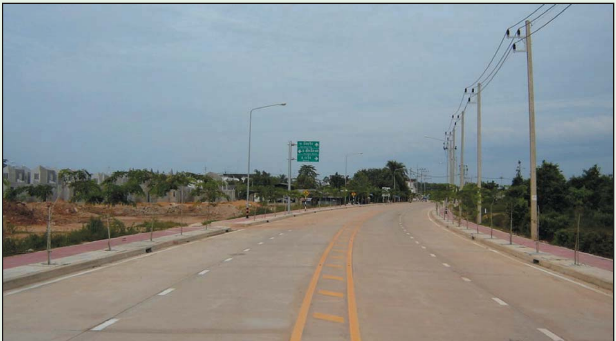
รูปที่ 1 - 1 ก่อสร้างถูกต้องตามแบบแปลน - มั่นคง - แข็งแรง - ปลอดภัยต่อประชาชน เป็นเป้าหมายสูงสุดของผู้ควบคุมงาน
