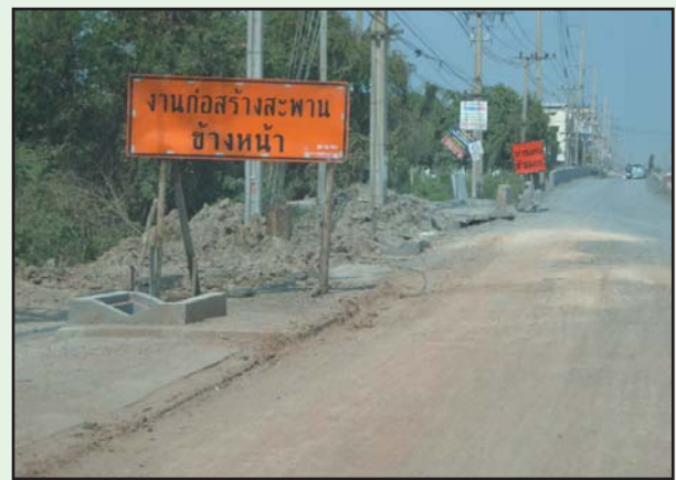
รูปที่ 1 - 3 (ข) การติดตั้งป้ายและสัญญาณควบคุม
