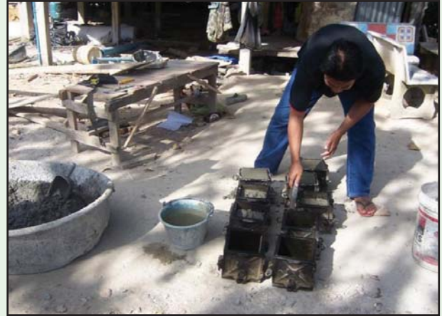
รูปที่ 5-30 เก็บตัวอย่างคอนกรีต เพื่อทดสอบกำลังอัด
