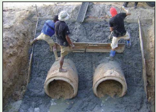
รูปที่ 5-38 การเสริมเหล็ก และการเทคอนกรีตกำแพงปากท่อ
