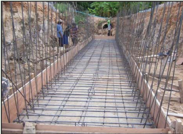
รูปที่ 5-22 การเข้าแบบหล่อและการเสริมเหล็กพื้นล่างท่อเหลี่ยม
