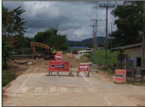
รูปที่ 5-20 การติดตั้งป้ายลูกศรบอกทิศทางการเบี่ยง
