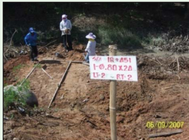
รูปที่ 5-7 ปักป้าย บอกตำแหน่ง ขนาด และจำนวน
