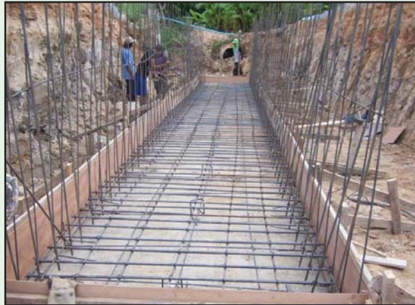
รูปที่ 5-25 รูปแสดงการเสริมเหล็ก
