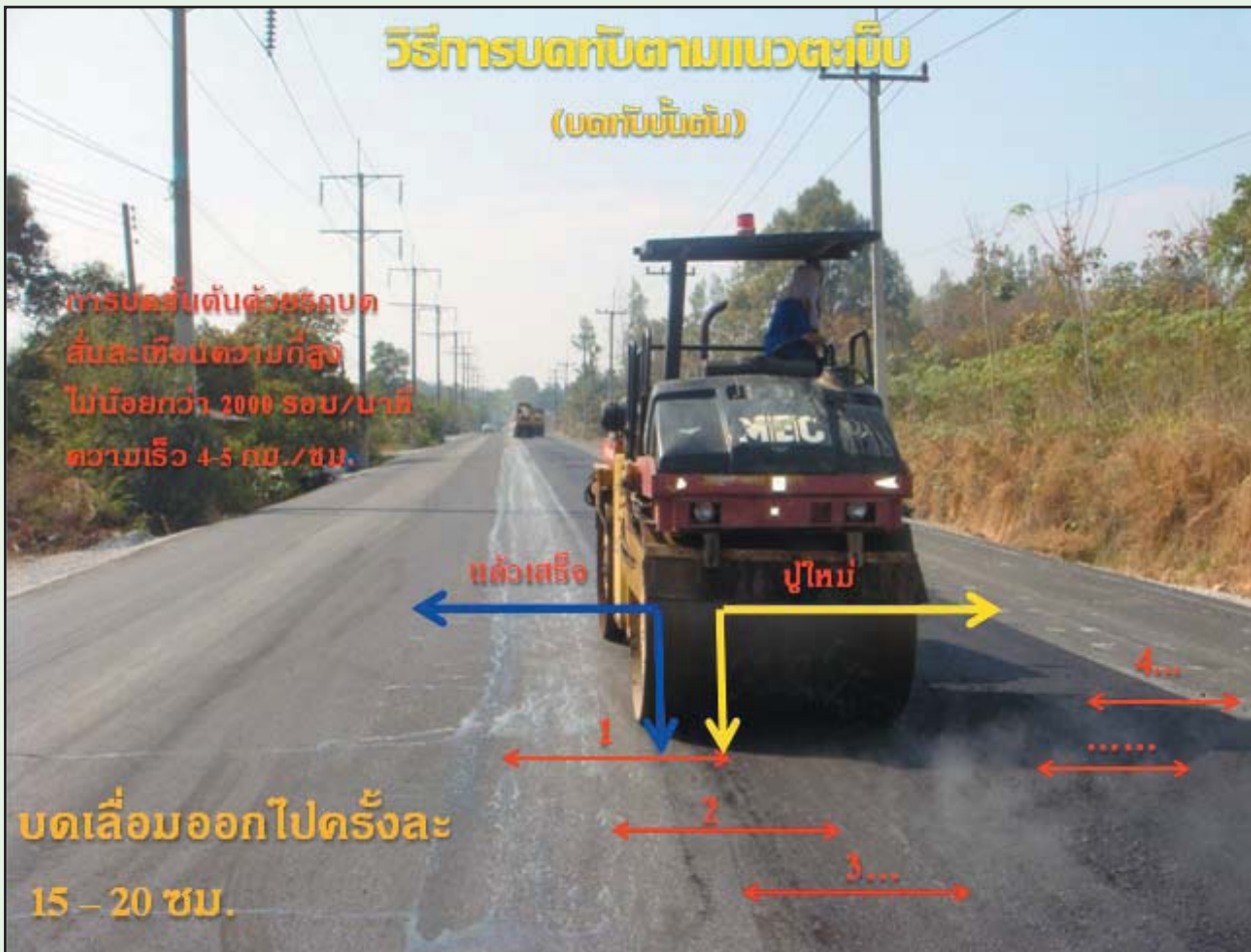
รูปที่ 6-33 วิธีการบดทับตามแนวตะเข็บ
