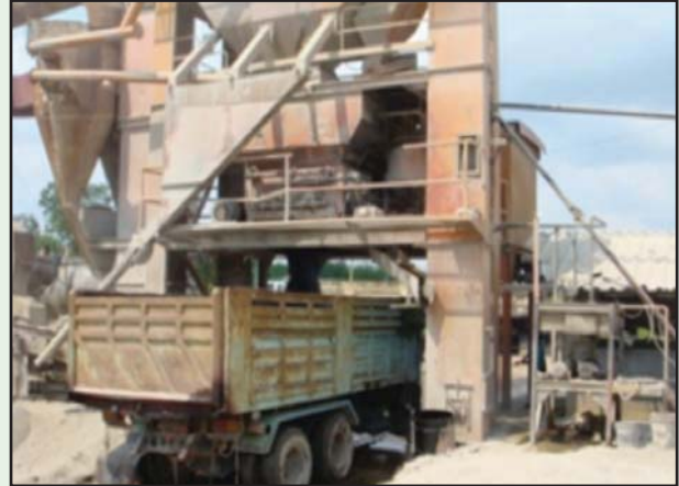
รูปที่ 6-15 ส่วนผสมแอสฟัลต์คอนกรีตถ่ายลงรถบรรทุกเพื่อขนส่งไปยังจุดก่อสร้าง
