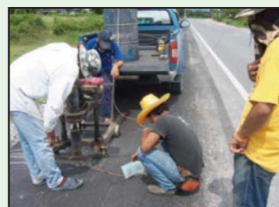
รูปที่ 6-38 การตรวจสอบคุณภาพชั้นผิวทางแอสฟัลต์คอนกรีต
