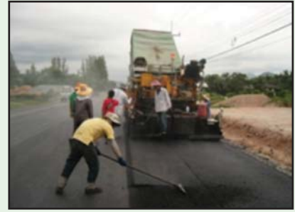
ควบคุมแนวการปู
