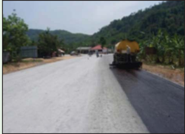
รูปที่ 6-6 ขณะดำเนินการลาดยาง
