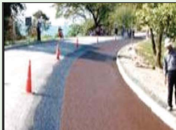
รูปที่ 6-45 ปิดกั้นรถไม่ให้เข้าบริเวณที่เพิ่งฉาบผิว
