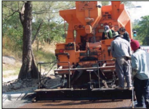
รูปที่ 6-42 เครื่องจักรผสมเสเลอร์ซีล
