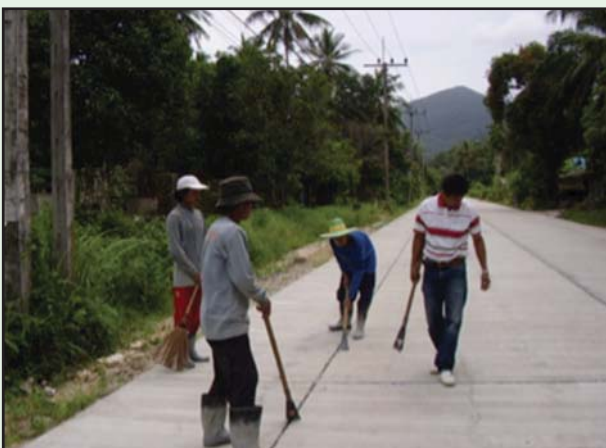
รูปที่ 6-66 กวาด ทำความสะอาด หรือใช้ลมเป่ารอยต่อ ก่อนหยุดเท
