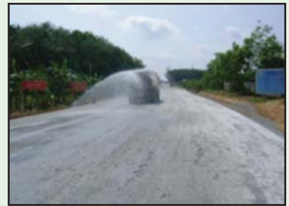
รูปที่ 6-4 สเปรย์น้ำให้ความชื้นก่อน
