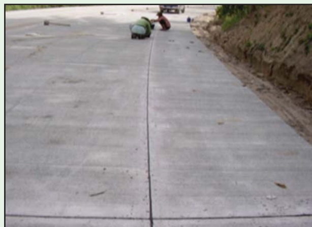
รูปที่ 6-66 กวาด ทำความสะอาด หรือใช้ลมเป่ารอยต่อ ก่อนหยุดเท
