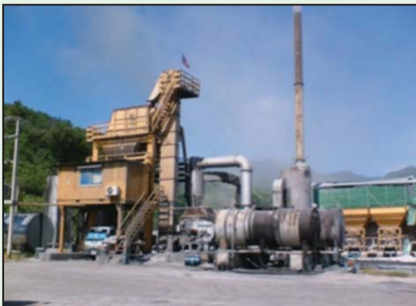
รูปที่ 6-12 โรงผสมแอสฟัลต์
