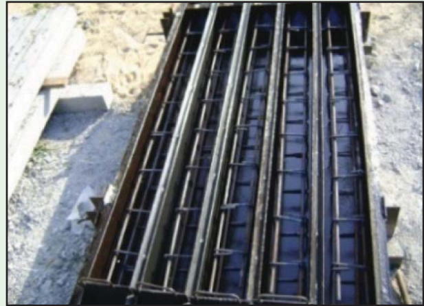
ตรวจสอบแบบหล่อ
