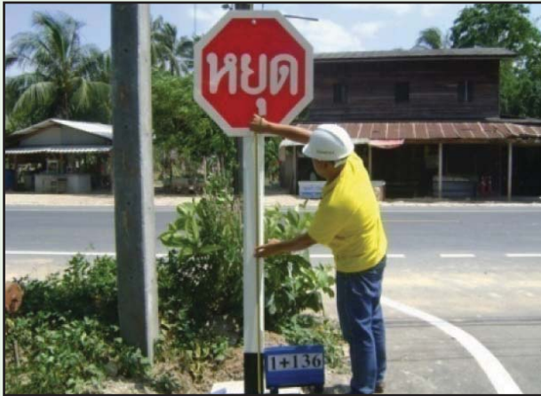
ตรวจสอบระยะ ต่าง ๆ หลังการติดตั้ง
