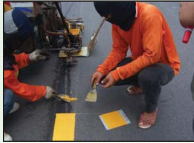
เมื่อสีแห้งยกแผ่นเหล็กมาตรวจสอบสี
