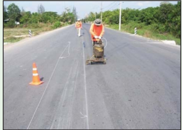
รูปที่ 7-8 การเตรียมการตีเส้นจราจร
