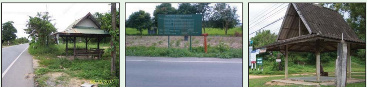
รูปที่ 8-4 ทรัพย์สินเดิมที่จะต้องมีการรื้อย้ายออกจากบริเวณก่อสร้าง
